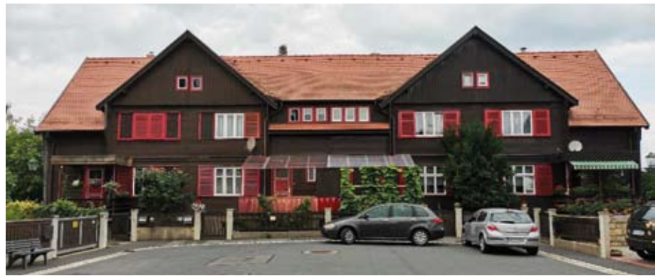
Holzhaussiedlung Dresden Stetzsch, errichtet 1927
